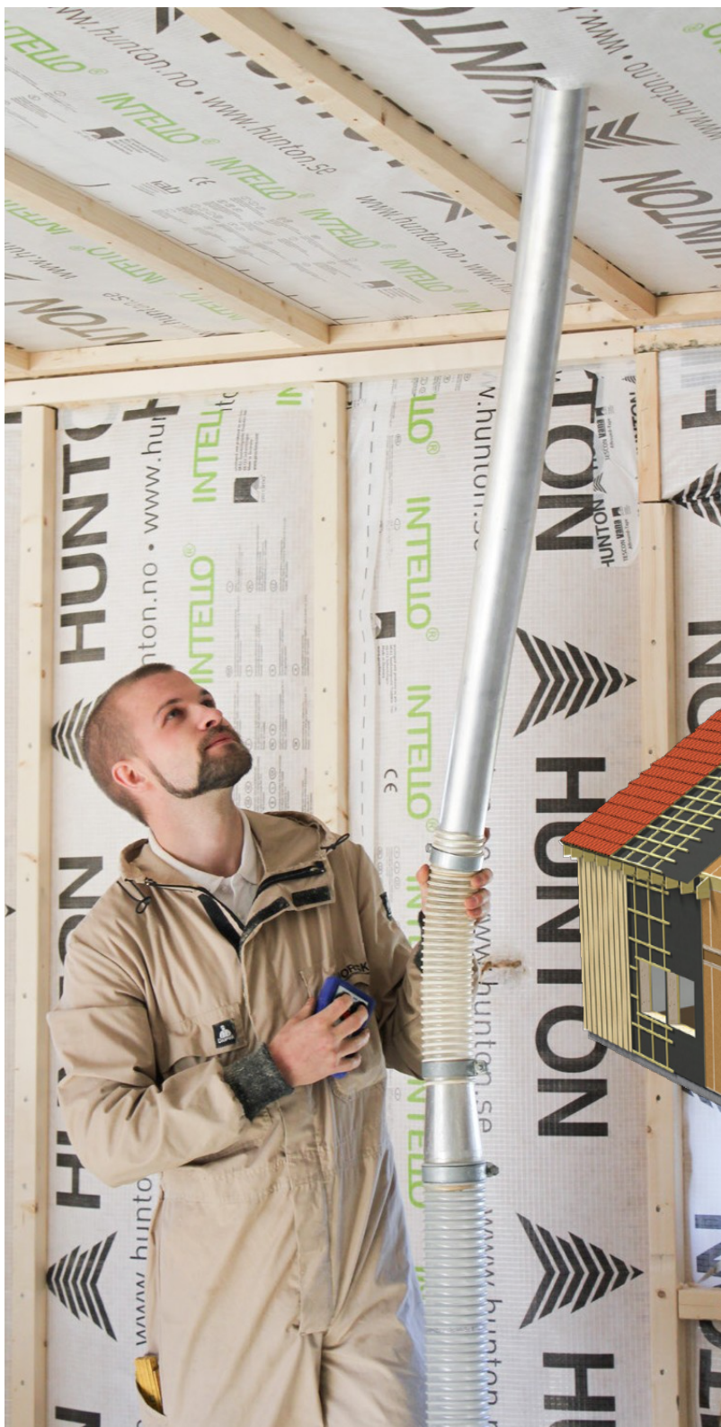
Iliustracijoje parodyta „Nativo“ medienos pluošto purškiamą izoliaciją, izoliuota siena.
